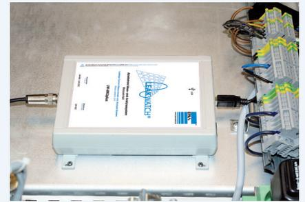
Unità di misurazione LW-MK3plus montata in un impianto di commutazione.
