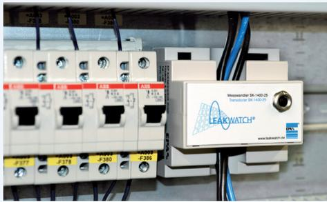
Trasduttore LW-SK1400-25 installato nell'armadio elettrico per il monitoraggio permanente della corrente di dispersione del cavo di alimentazione.
