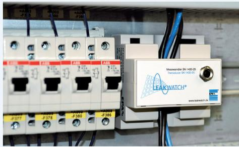
Wandler LW-SK1400-25 eingebaut im Schalt-schrank zur permanenten Ableitstromüber-wachung der Zuleitung.
